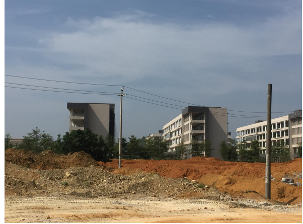
项目起点西南面柳州市二中
