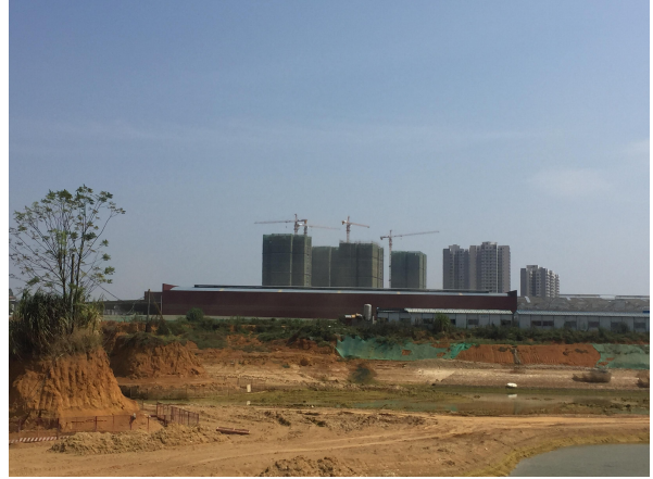
项目起点南面施工营地
