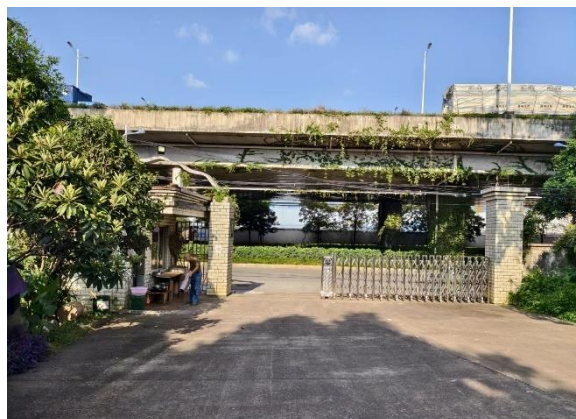
项目东面道路及高架桥
