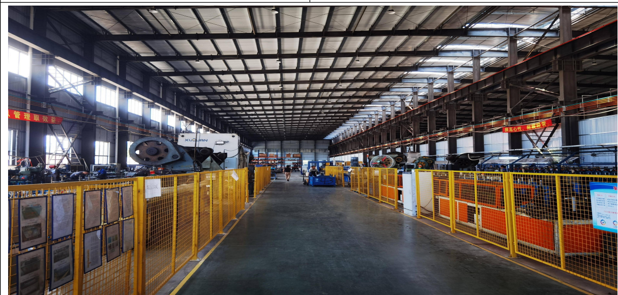
项目场址现状
