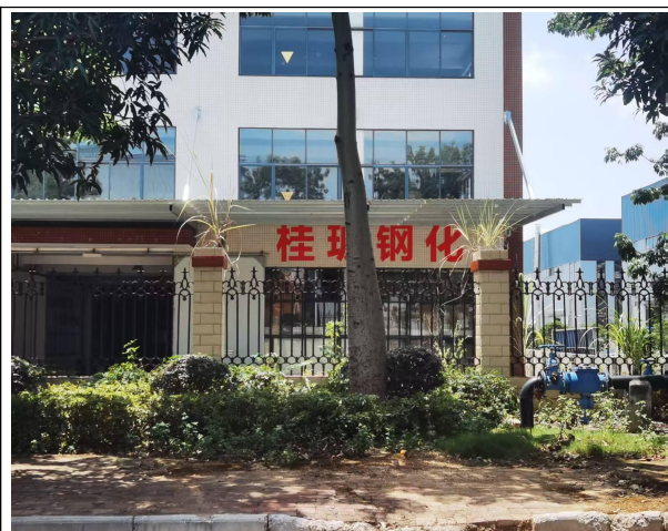
项目厂界北面
