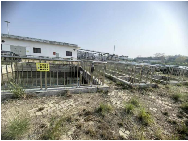
项目雨水收集沉淀池
