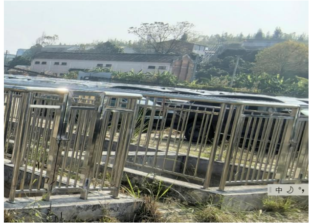
项目南面盐厂屯
