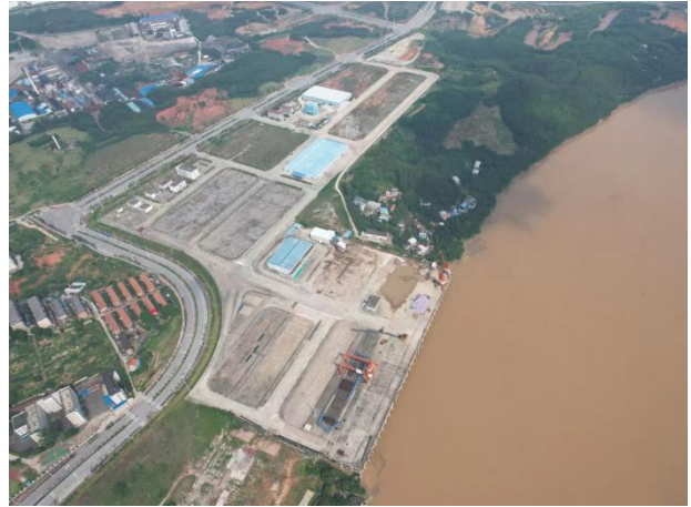
项目港区航拍图
