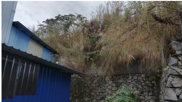
项目东南面现状
