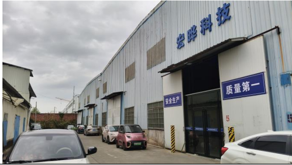
项目车间西北面通道及东北面仓库现状
