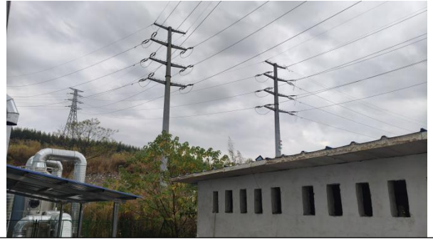
项目西南面现状
