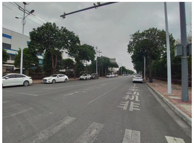
项目北面车园横四路
