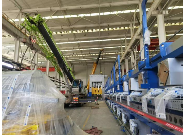
项目热成型生产线设备安装现场
