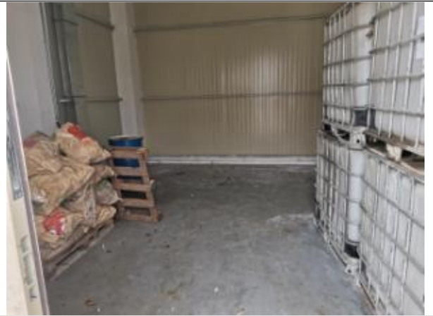
现有危废暂存间
