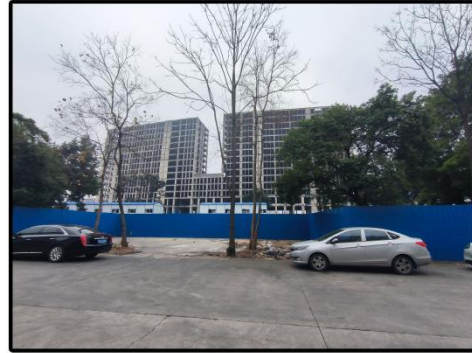
南面建筑工地
