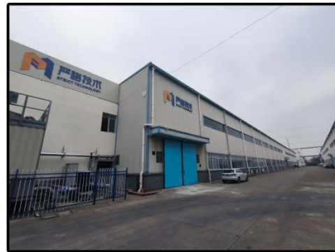
北面3#厂房及园区道路
