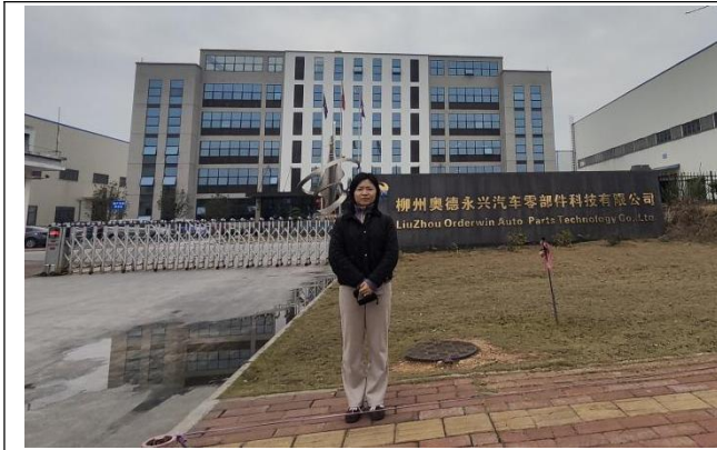
工程师现场踏勘
