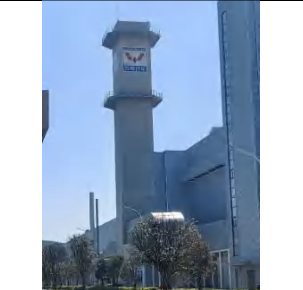
RTO系统及DA013排气筒
