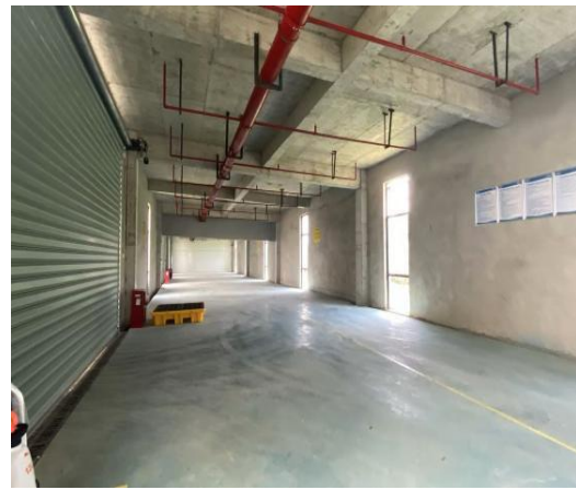
现有危险暂存间
