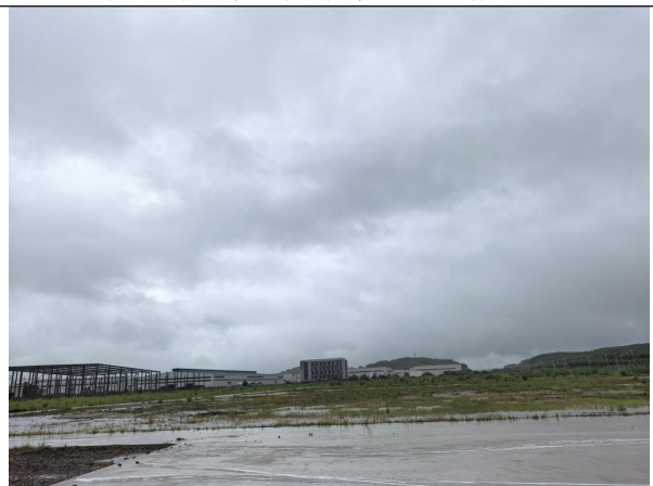
项目西南面柳州智能交通产业园
