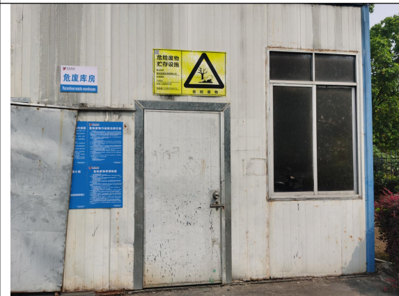
现有工程危险废物暂存间
