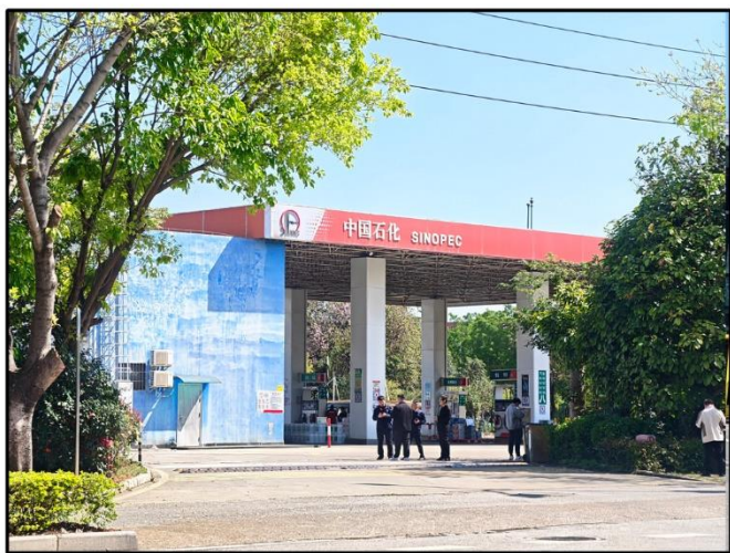
项目东南面的加油站
