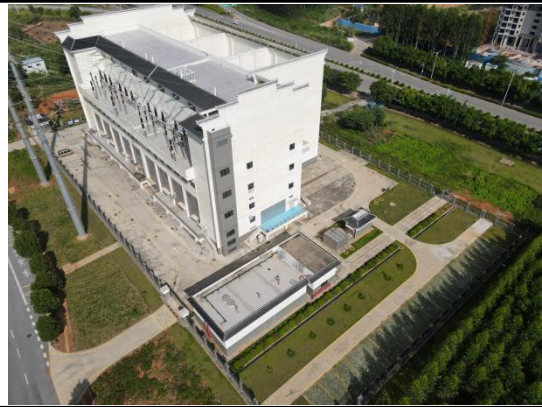
变电站四周临时施工场地均已恢复
