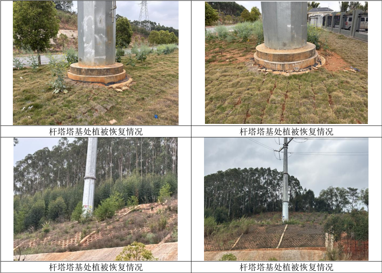
图 4-3 本项目输电线路杆塔塔基处植被情况
