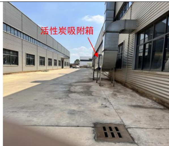
现有发泡、脱模配套活性炭吸附装置
