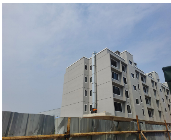
线束车间南面
