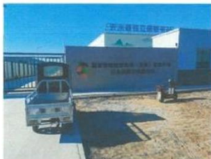
项目现场照片
