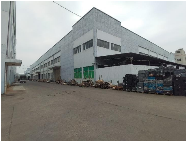
项目所在及东面的 2 号厂房
