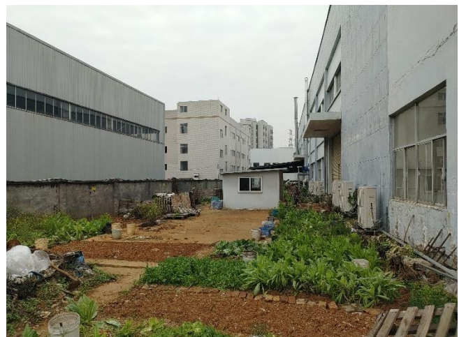
项目厂房北面现状
