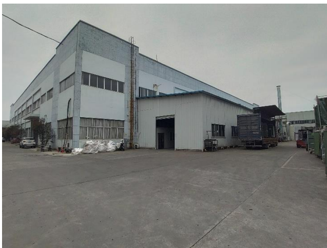
项目西面厂房现状
