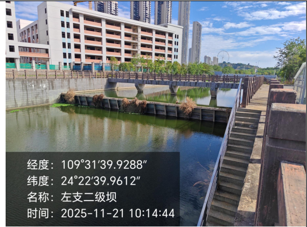
左支（下段）二级坝
