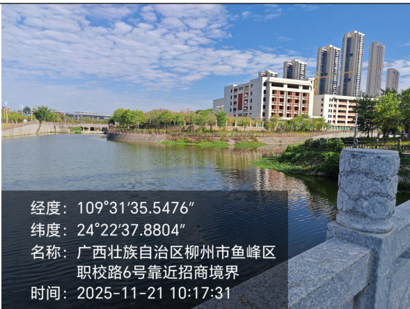
主支（中段）起点、主支（下段）终点、 左支（下段）起点及主支（中段）二级坝
