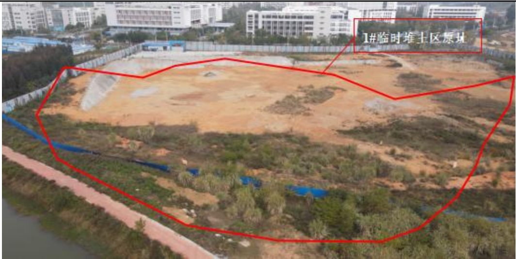
图 2-9 1#临时堆土区现状图
