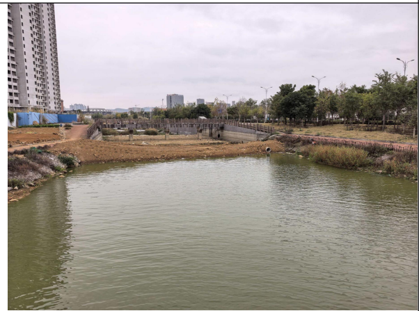
主支（中段）三级坝
