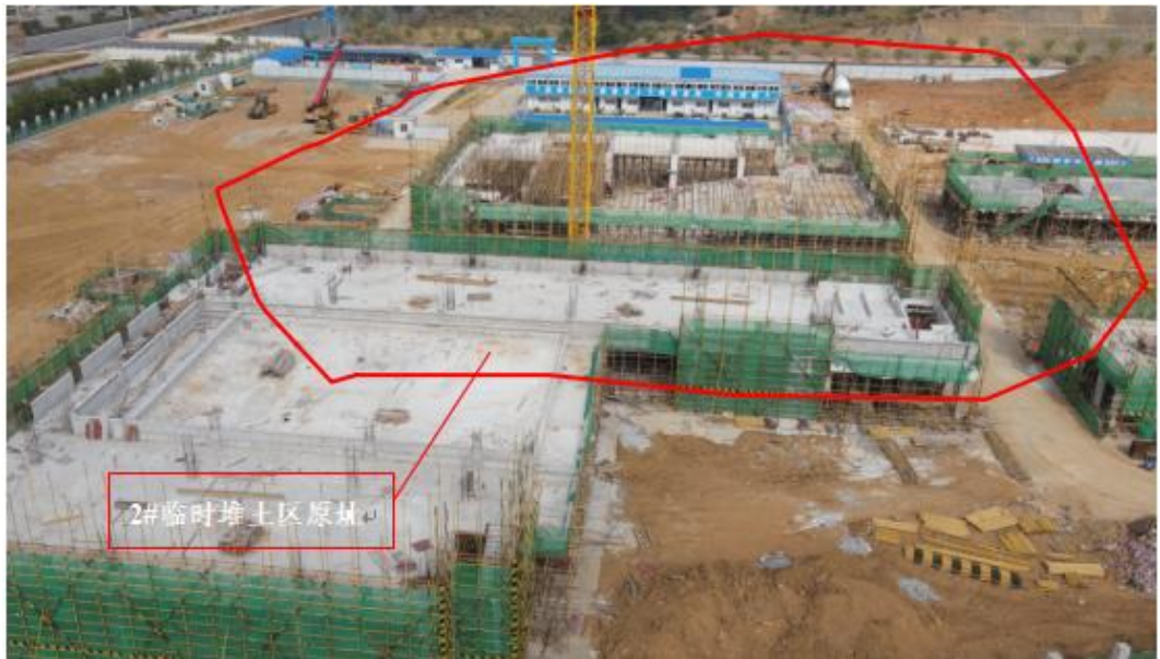
图 2-10 2#临时堆土区现状图
