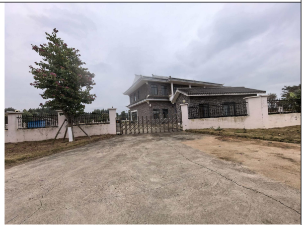
泵站管理用房
